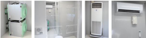
写真左から■抗ウイルス HEPA (ヘパ) フィルター内蔵換気装置／■検査窓(開閉式) 隔離タイプのみ／■エアコン／3馬力／■エアコン／2馬力
