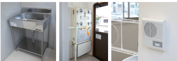
写真左から■流し台／■抗ウイルス H EPA (ヘパ) フィルター内蔵エアシャワー／■インターホン (D、E、Fのみ)
